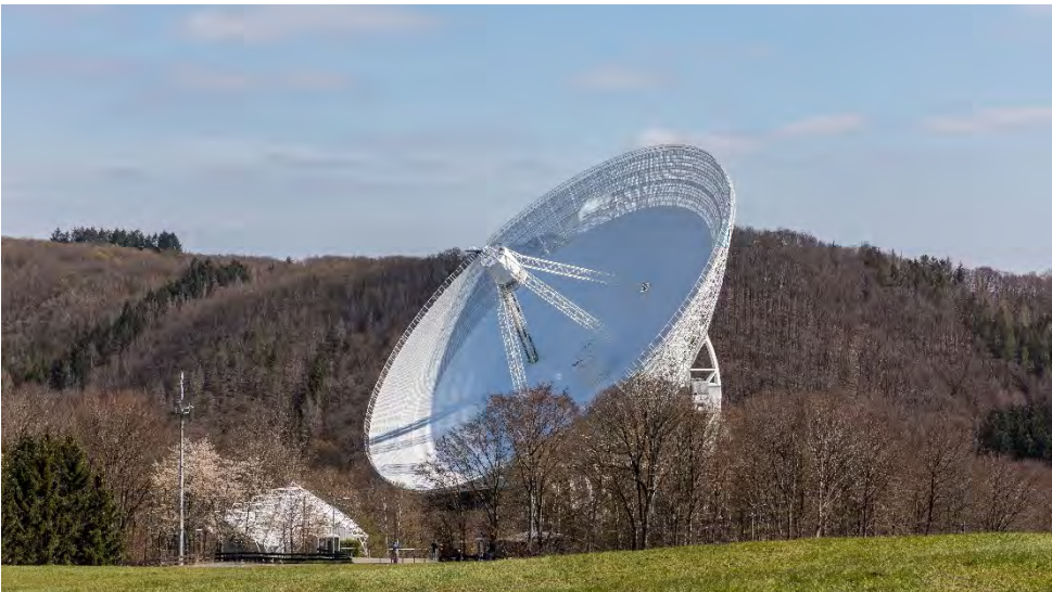
Rys. 8.7. Zdjęcie przedstawia radioteleskop Effelsberg z ruchomą anteną paraboliczną o średnicy 100 metrów. Radioteleskop uruchomiono w roku 1972 w Nadrenii-Westfalii w Niemczech.
